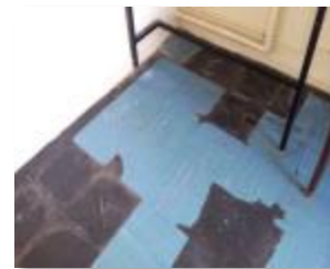
dalles de sol
